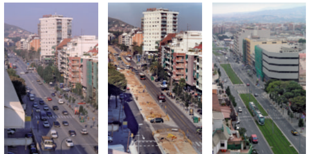
Figura 21: Renovación urbana en la carretera C-245 de Esplugues a Cornellà.
