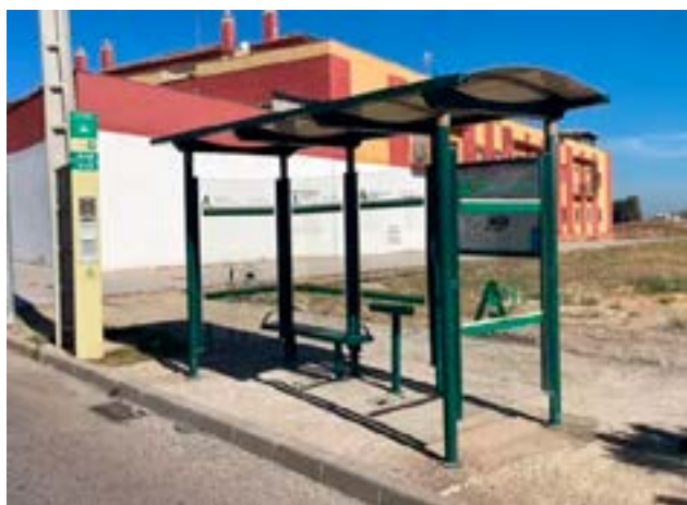
Nuevas marquesinas instaladas, 2022. Fuente: Europapress. Titular: "El Consorcio de Transportes de Sevilla instala nuevas marquesinas accesibles y con planímetros en paradas de autobuses".
