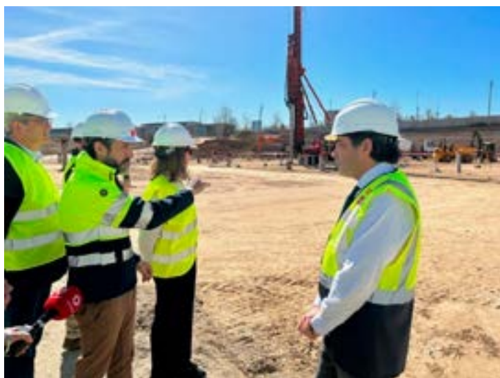
Obras intercambiador de Valdebebas, 2023. Fuente: Comunidad de Madrid.
