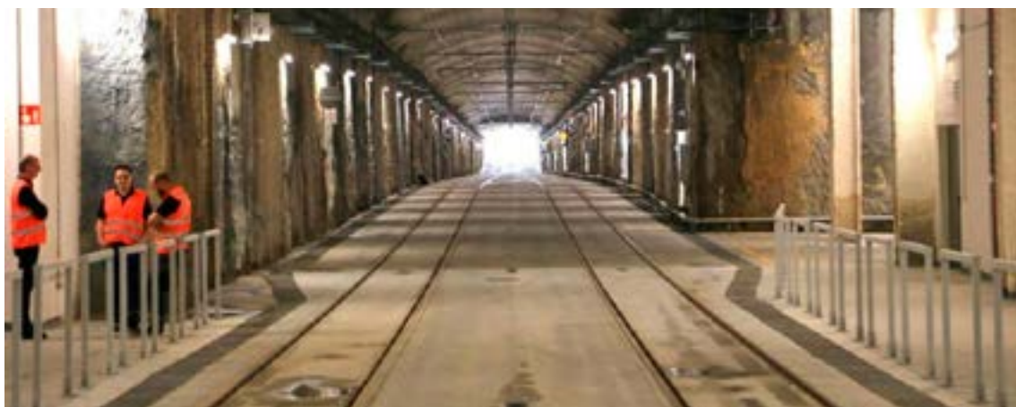
Fuente: Valencia extra, 2023. Titular: "Avanza el túnel peatonal que conectará la línea 10 con Metrovalencia"
